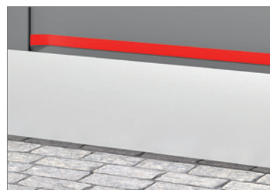
Collage des baguettes de finition
